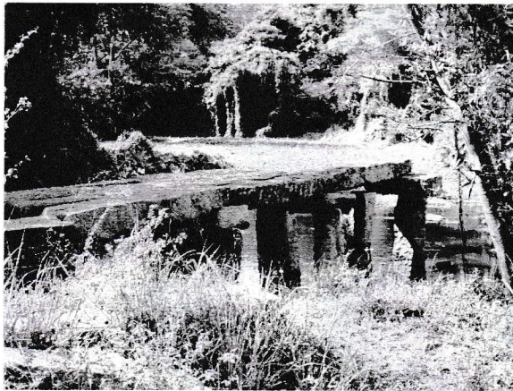
ඡායාරූපය 7: අනුරාධපුර උතුරු ගමන් මාර්ගය හා සම්බන්ධ වන මල්වතු ඔය හරහා ඉඳි කර ඇති ගල් පාලම
