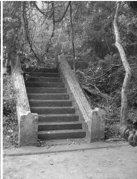
ජායාරූප අංක 39 ප්‍රධාන පෙත්මගෙන් බටහිර දෙස පර්වත පෙදෙසෙහි පවත්නා ස්මාරක වෙත ප්‍රවේශ වීම සඳහා සකසා ඇති පියගැටපෙළ
