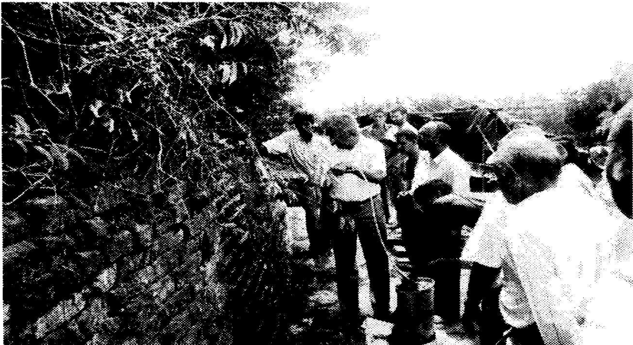
ඡායාරූපය 5: රෝලන්ඩ් සිල්වා විසින් කුස්තුර තුළට බදාම විදීමේ ක්‍රමය අත්හදා බලමින් (ඡායාරූපය: මායා උපනන්ද, මධ්‍යම සංස්කෘතික අරමුදල)
